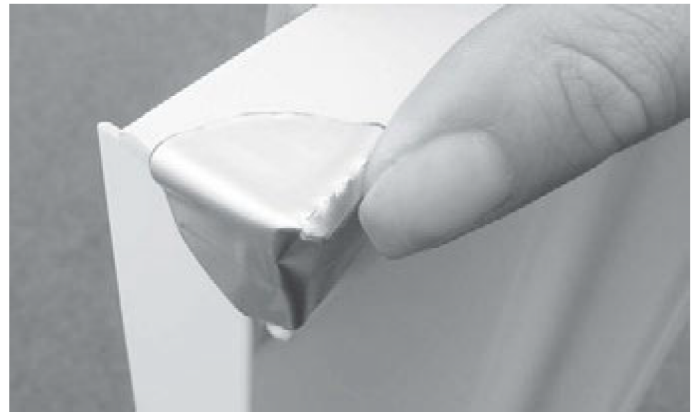
4. Kleef de stootvoeg aan de zijkant vast 4. Connect butt-joint on the edge
