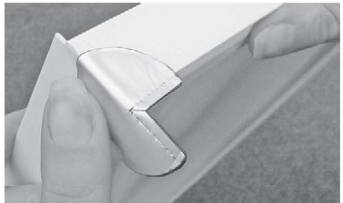
2. Kleef vervolgens rond de voeg 2. Following glue around the gap
