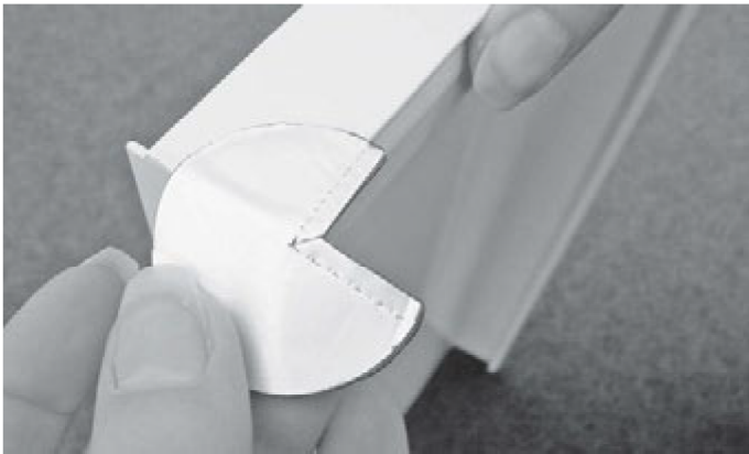
1. Fixeer DFT 40 aan het eindstuk van de vensterbank 1. Fix DFT 40 at the windowsill end seal
