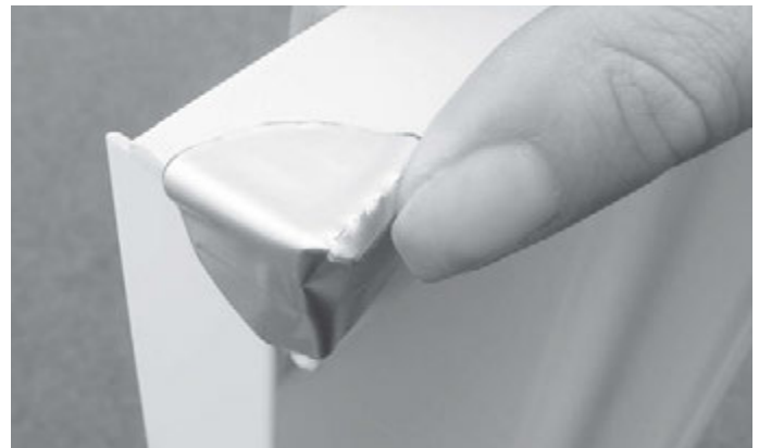
4. Stoßfuge an der Kante verbinden 4. Connect butt-joint on the edge
