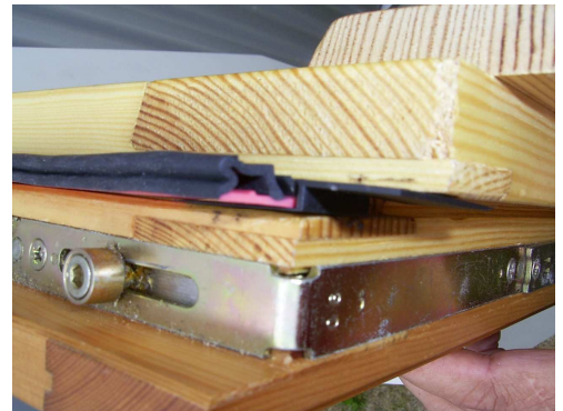
Montage achter de dichtingsrug.
